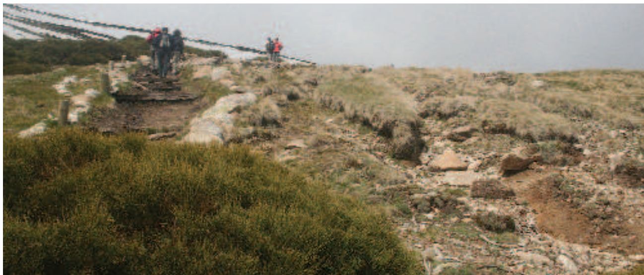
Foto 19. Delimitación de la caja del sendero, demarcación con piedras y sujeción de suelo, a través de traviesas de madera. Estas actuaciones se llevaron a cabo como medidas de restauración ante la erosión, los daños a la vegetación y la proliferación de senderos secundarios (Parque Regional Sierra de Gredos, área de "Los Barrerones". Ávila).
